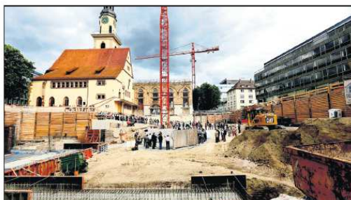
Im Sommer ist der Grundstein für den neuen Hospitalhof gelegt worden. Foto: Zweigarth
