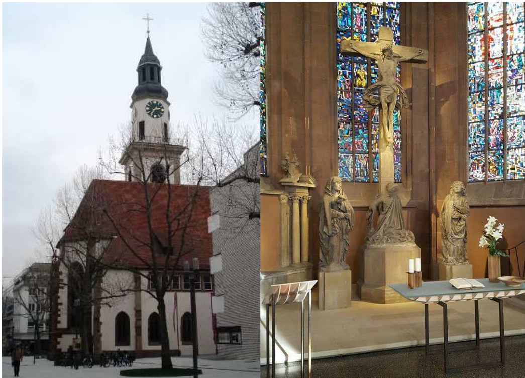
Hospitalkirche nach der Sanierung
